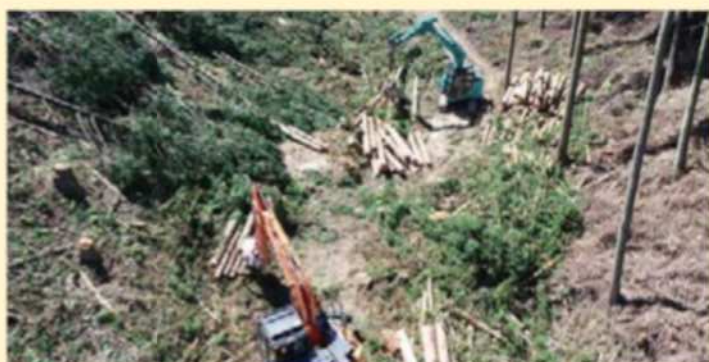
ドローンによる施工管理
