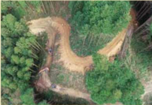
リモートセンシングによる現場作業
