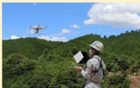
ドローンによる施工管理・測量
