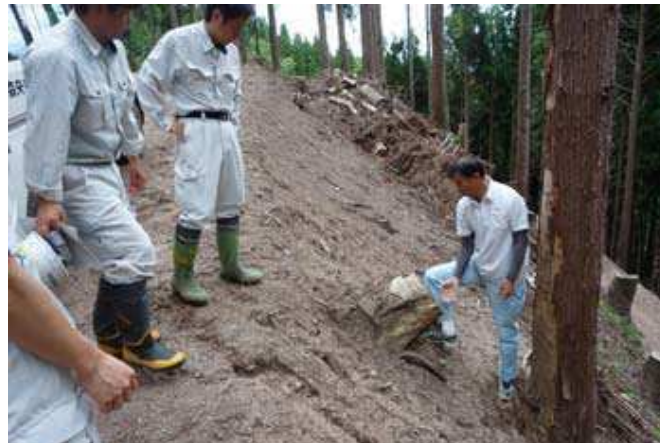
開設済み作業道の施工検証
