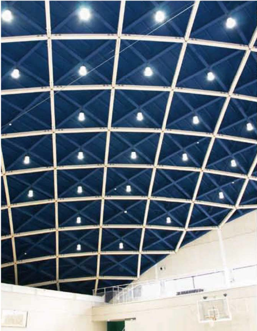
屋内運動場 ...くじらを思わせる球状のシェル天井。スポーツの場所として伸びやかなフレームラインと星空のような照明で躍動感を表現。補助ブレースに市有林材枠を使用。
